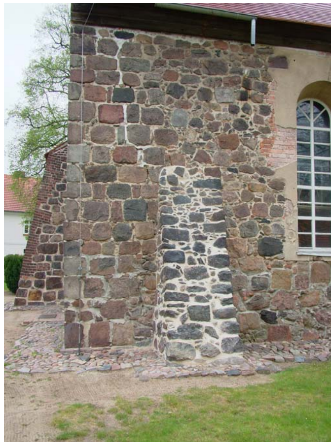
Bild 03 – verputzter Strebepfeiler an der Südseite
