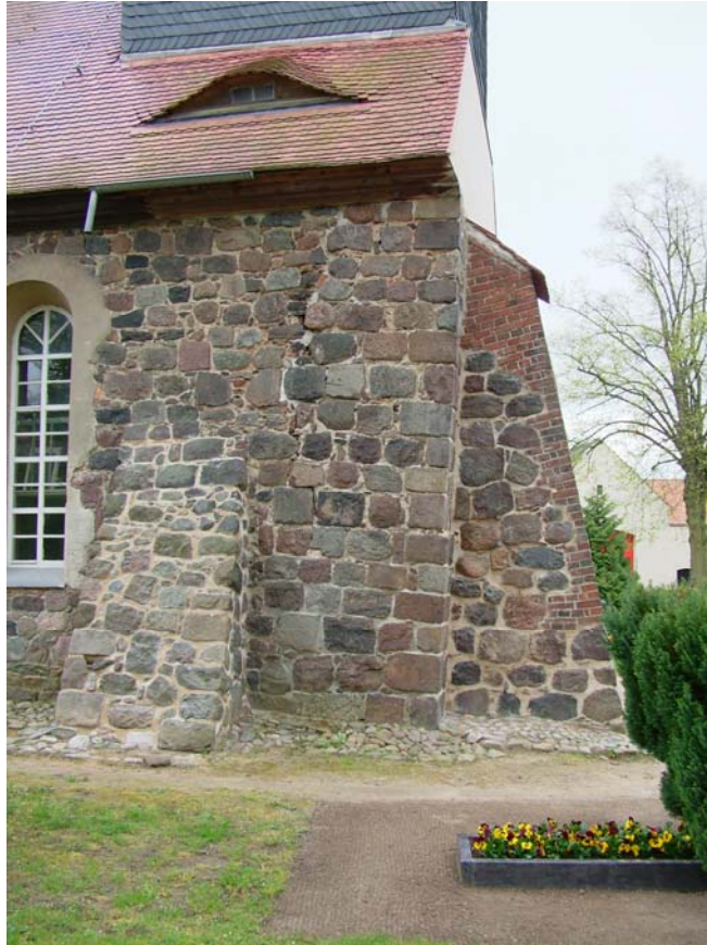
Bild 04 – Strebpfeiler an der Nord- West- Ecke der Kiche
