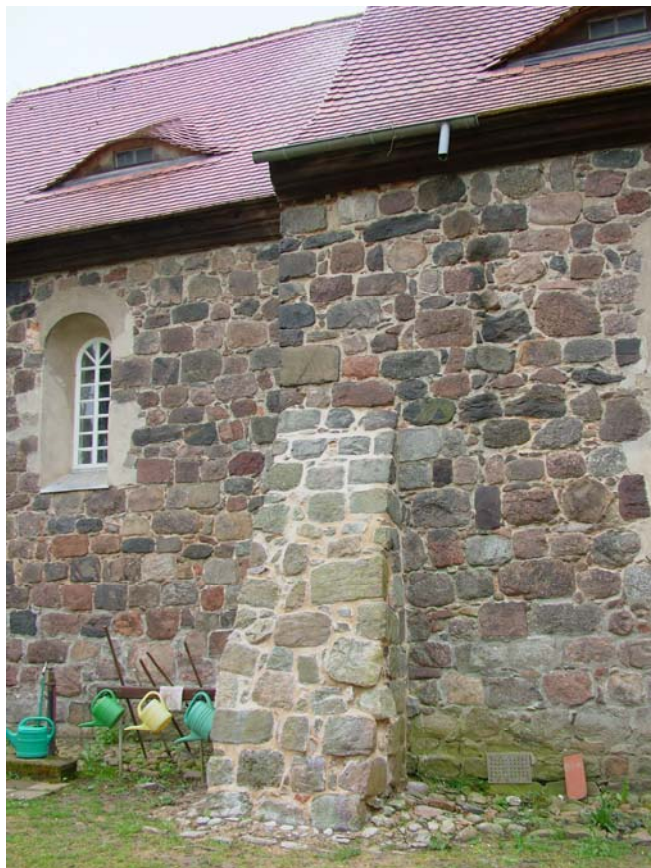
Bild 05 – verfügter Strebpfeiler an der Nordseite am Ende des Kirchenschiffes
