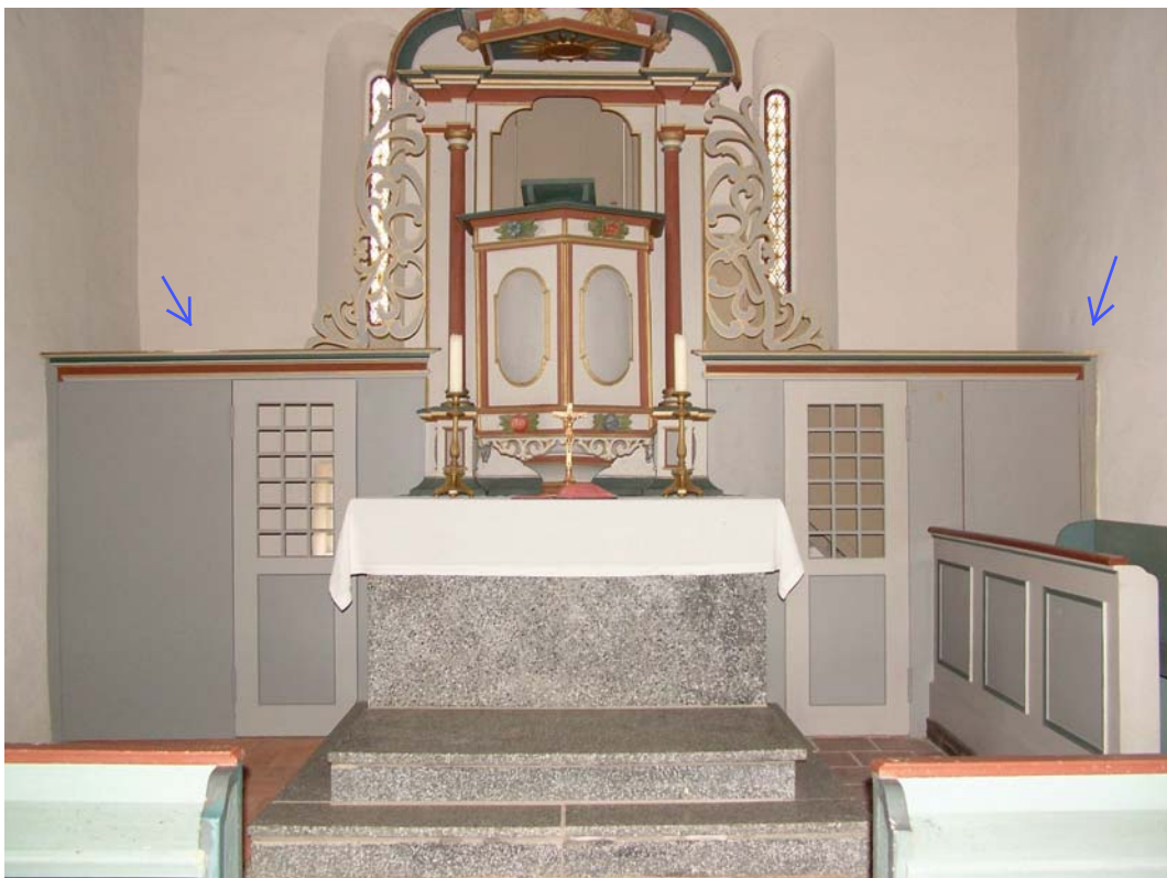
Bild 07 – Montage der linken Trennwand incl. Farbgebung
