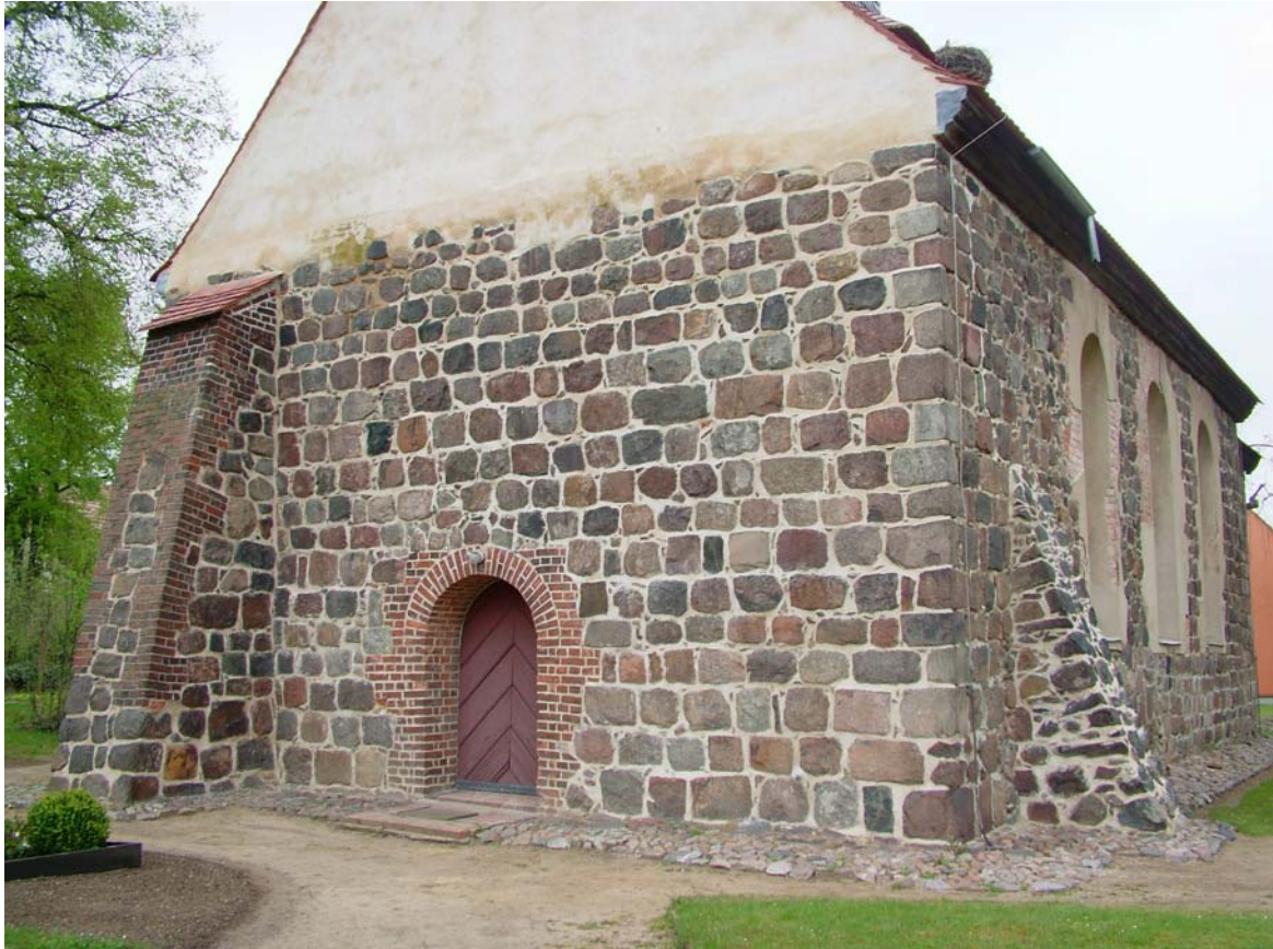
Bild 02 – Westansicht, verputztes Feldsteinmauerwerk incl. der Strebepfeiler
