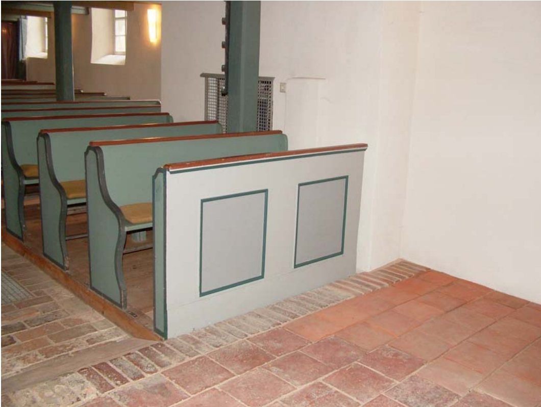
Bild 06 – Montage der vorderen Sitzbankblende mit Buchablage incl. Farbgebung
